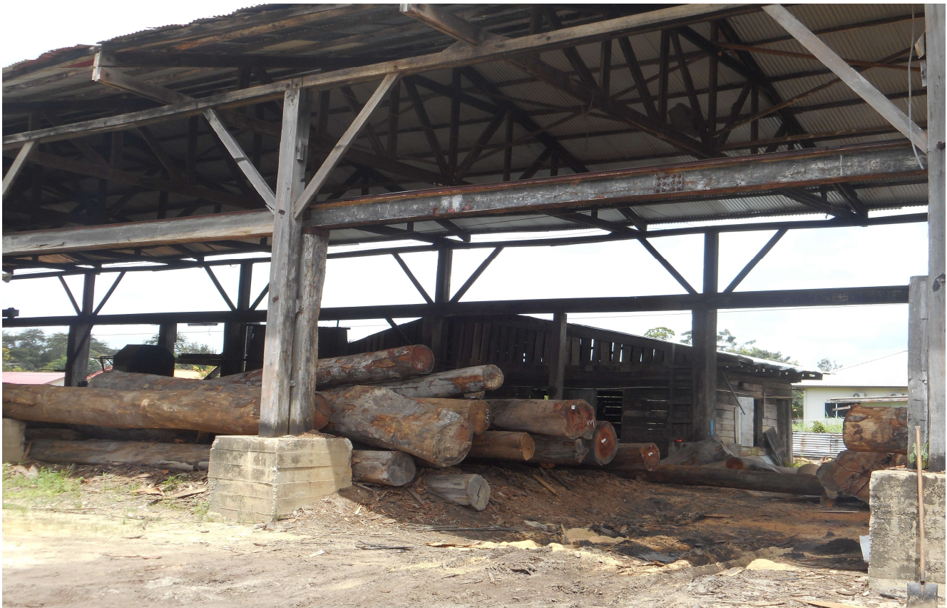
Figuur 4. Rondhout opslagplaats onderdak
